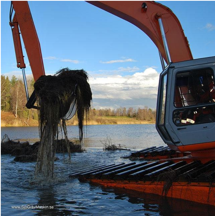
Figur 9. Grävning med pontongrävare.
